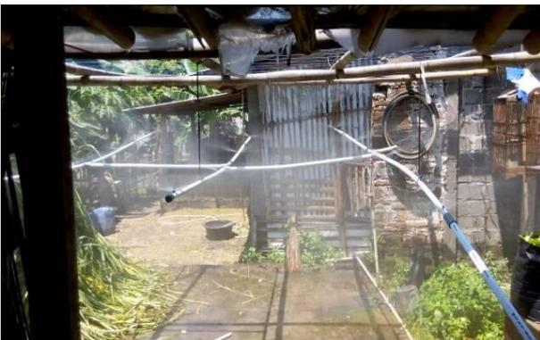
Gambar 4 Saat alat spray otomatis menyala di dalam kumbung jamur
