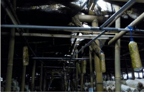
Gambar 3 Struktur perpipaan pada alat spray air di kumbung jamur
